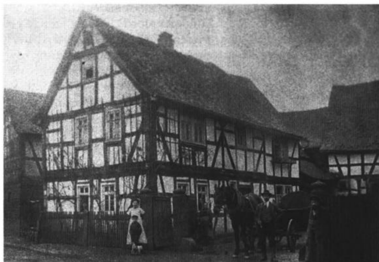
Haus Hauptstraße 39, nach 1900
