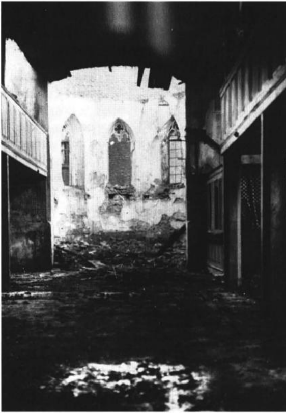
Innenraum der Düdelsheimer Kirche nach dem Brand 1919
