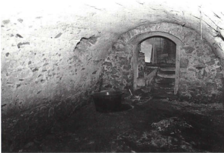
Bis auf den Lehm Boden reicht das meterdicke Feldsteingewölbe (I. Rana).
